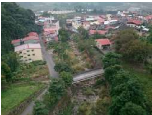
照片 3、村內房屋比鄰溪流而建，以橋樑聯接溪流兩岸聚落
